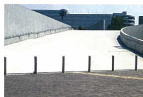
グレー(N6)施工
